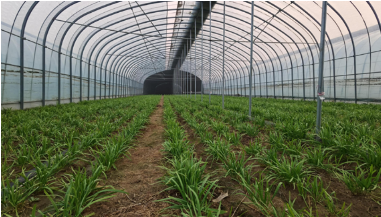
扶沟县韭园镇绿久蔬菜发展科技园区水毁重建项目
